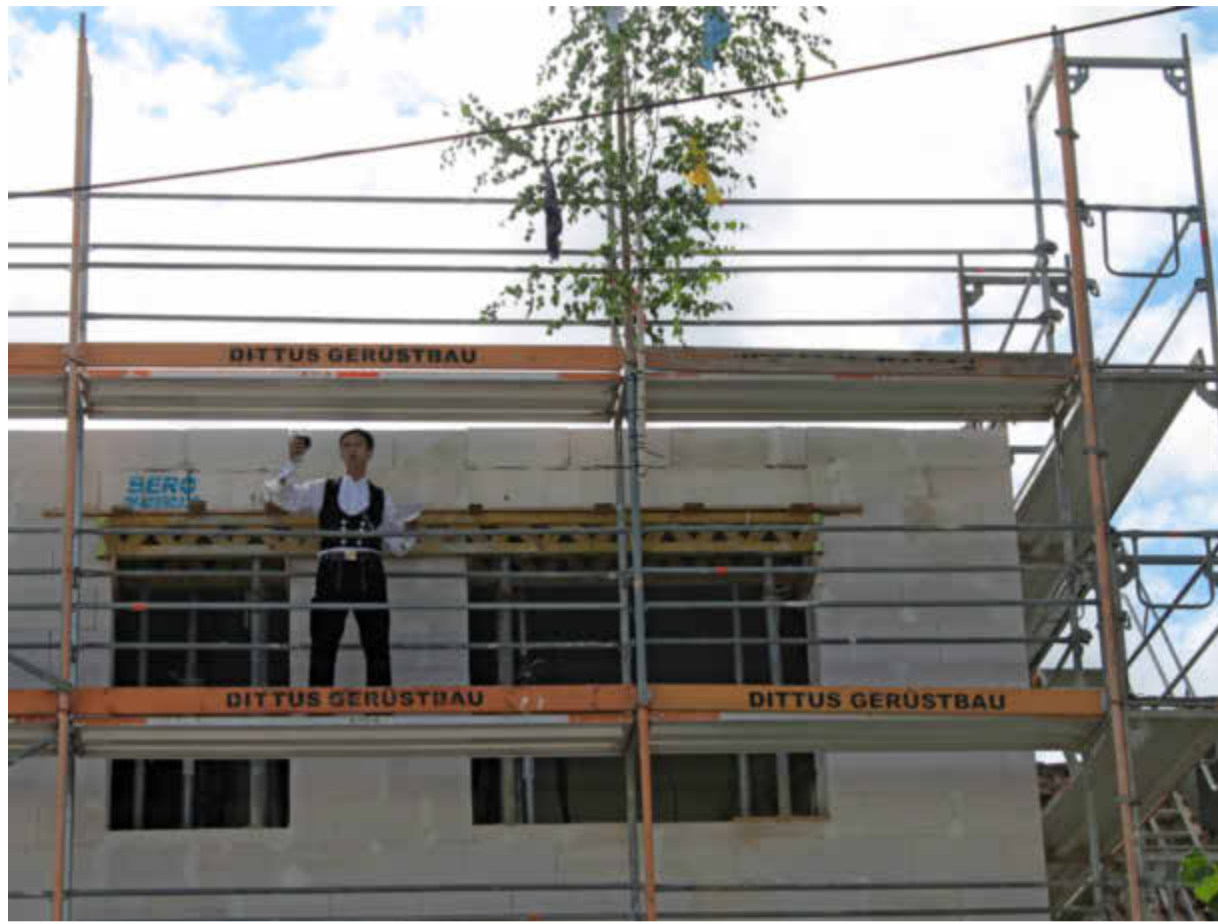
Mit Blick in Richtung Rathaus wünschte Zimmermann Thomas Schneckenburger beim Richtspruch den Segen für das Ensemble. Es besteht aus drei Wohngebäuden, Gewerbefläche im Erdgeschoss und darunter liegender Tiefgarage. Fotos: Zwingmann
