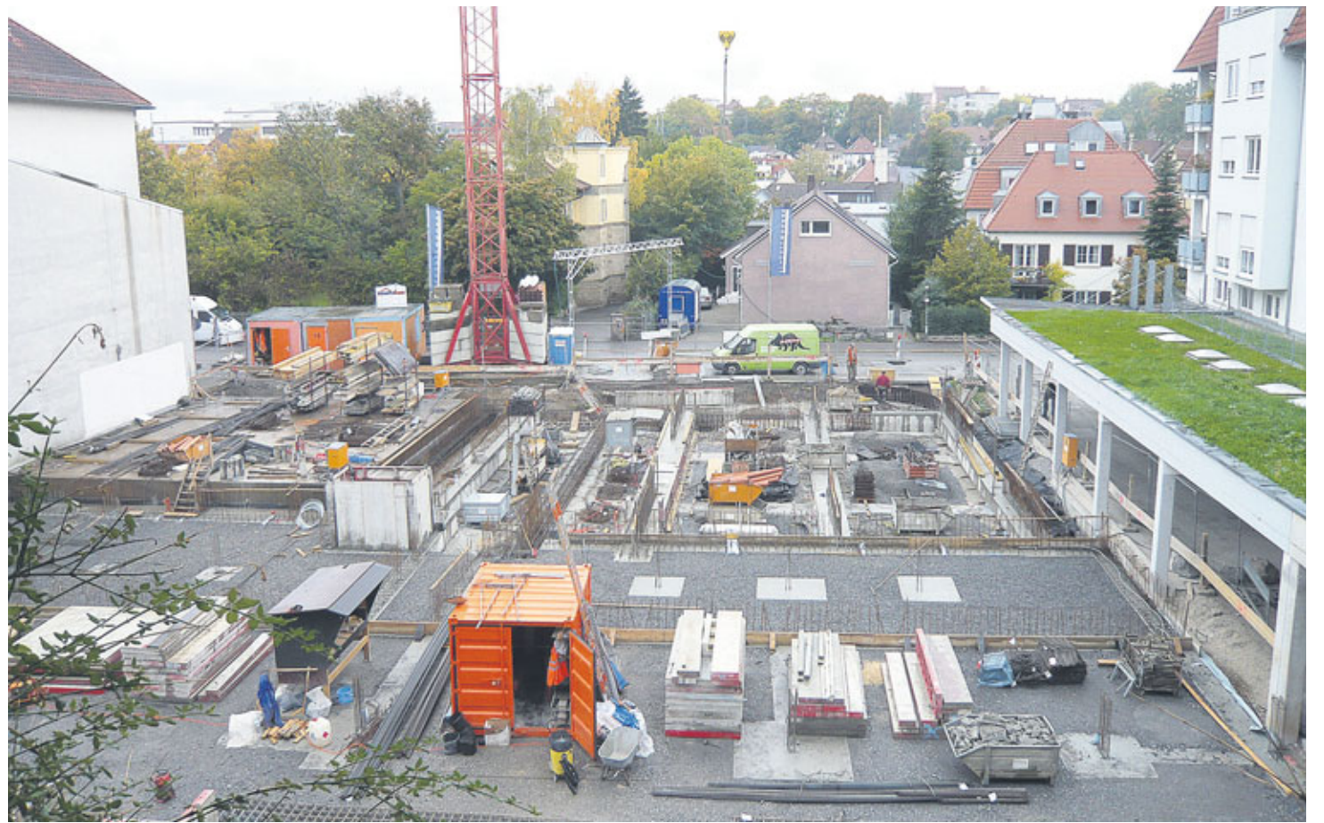
In der Gartenstraße, nahe des Denkmals Körner'scher Turm, sind die Bauarbeiten am StadtCarré im Gange.
