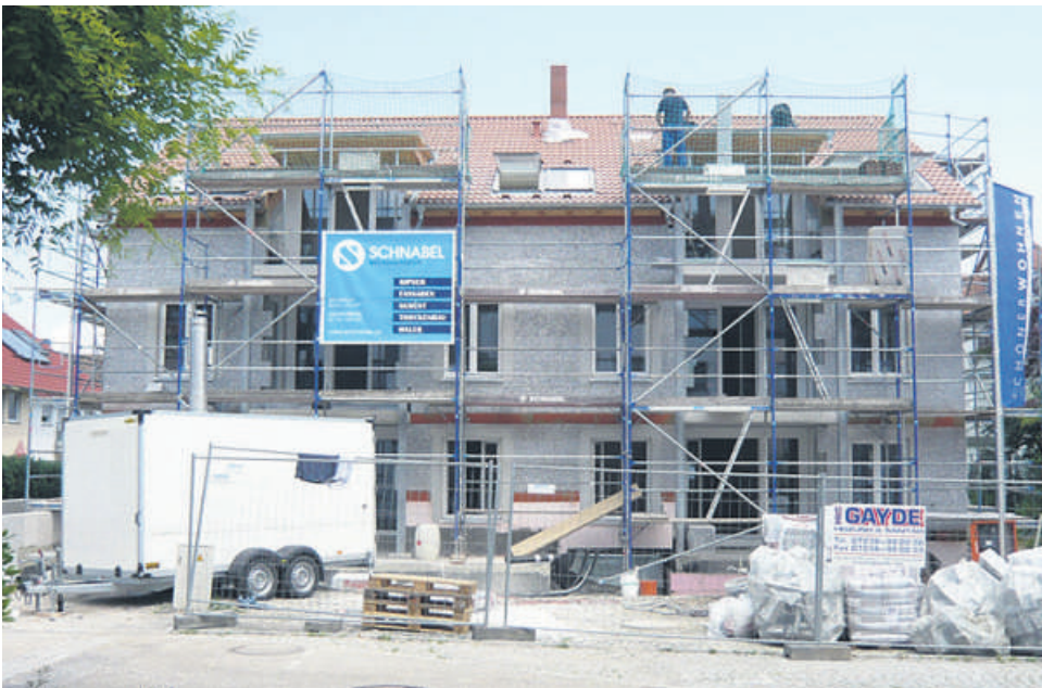
In Freiberg läuft der Innenausbau und an der Fassade fehlt nach dem Einbau der Wärmedämmung nur noch der Außenputz. Foto: SCHÖNER WOHNEN
